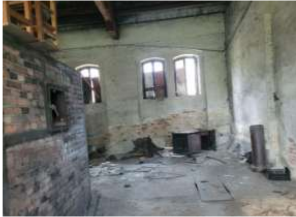
Fot.9. Widok ogólny, odpadnięty tynk, zniszczona posadzka, wybrakowana stolarka okienna Autor: Tomasz Strzałka
