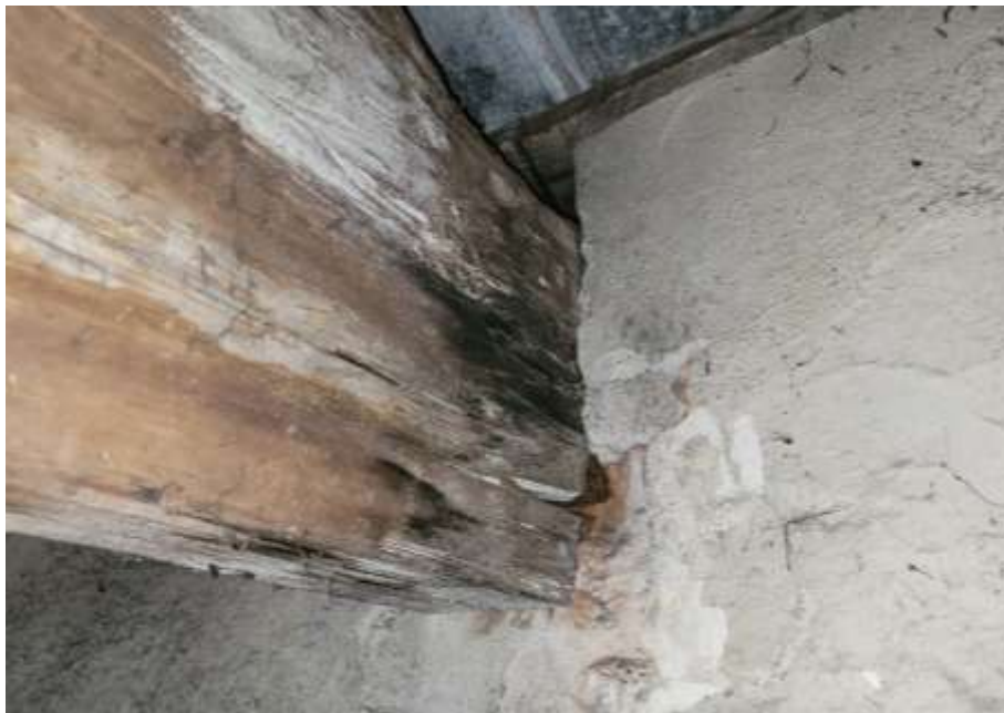
Fot.3. Stan awaryjny dźwigara kratowego
