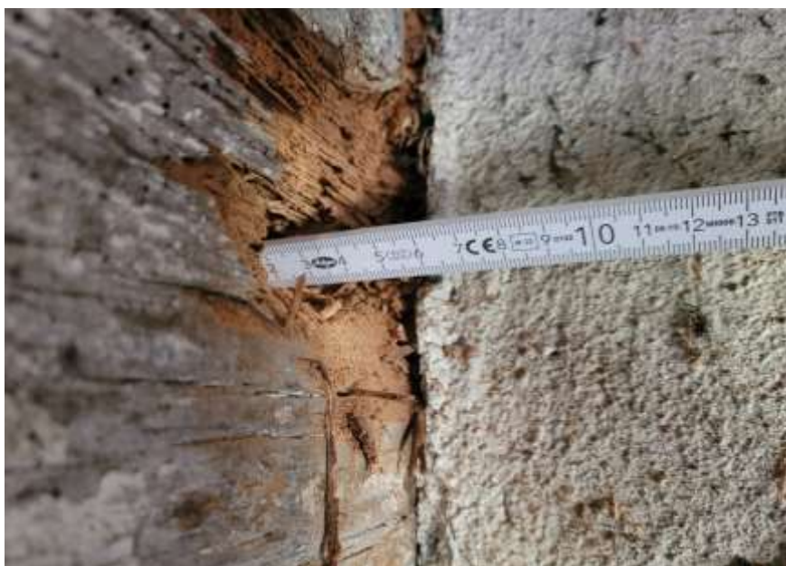
Fot.4. Odkrywka w miejscu styku drewna z murem
