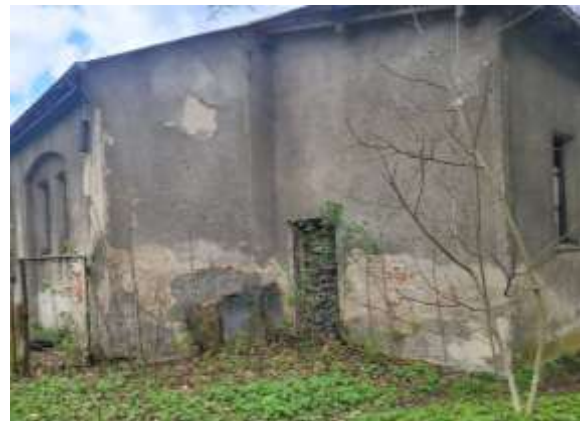
Fot.8. Zawilgocenie, odpadający tynk Autor: Tomasz Strzałka
