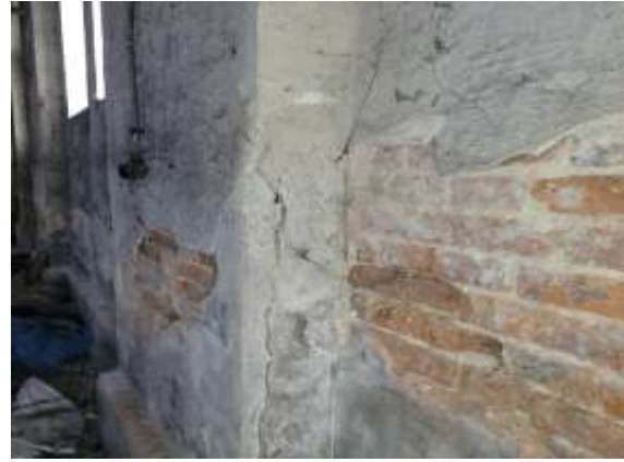
Fot.10. Odpadnięty tynk Autor: Tomasz Strzałka
