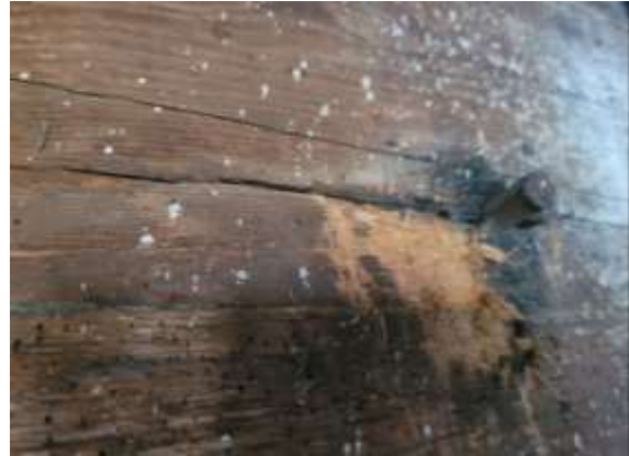
Fot.6. Zdegradowany element konstrukcji Autor: Tomasz Strzałka
